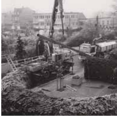
Kransen er ved at være på plads og klar til at blive hængt op i den 15 m høje mast.
